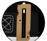
Partes metálicas golpeadas o picadas
