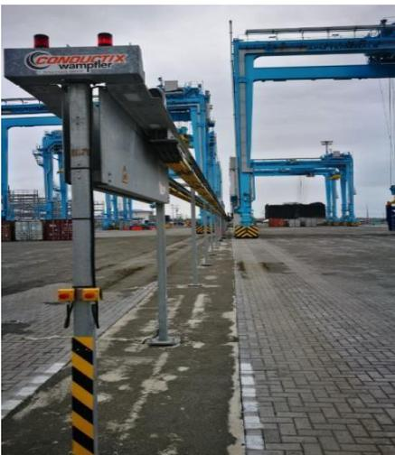
Figura 23. Busbar en bloques C y D del patio de la TCM.
