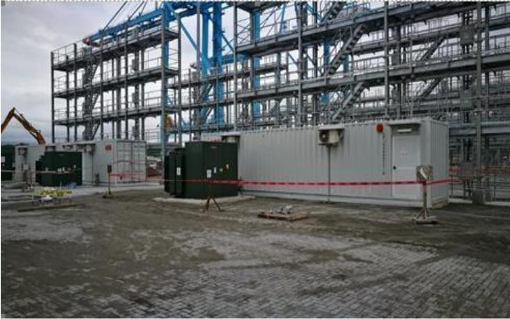
Figura 22. Subestaciones marca ABB para las grúas eRTG.
