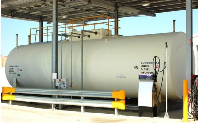
Figura 30. Imagen con carácter ilustrativo de estación combustible similar a la que será instalada en la terminal.
