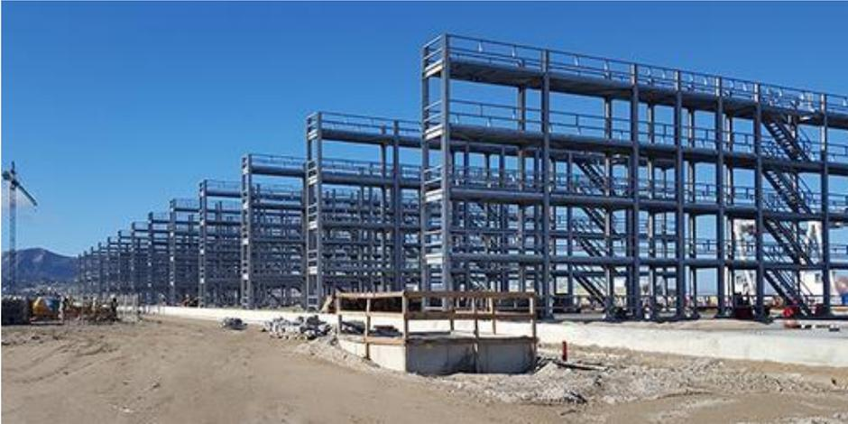
Figura 28. Imagen de estructuras de Reefer Racks en la Terminal de Contenedores de Moin.
